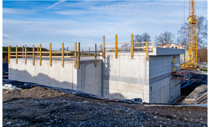
Rohbau Reservoir Blattweid
