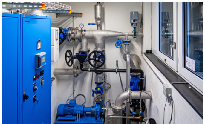
Sanierte Brunnenstube Lüthärtigen
