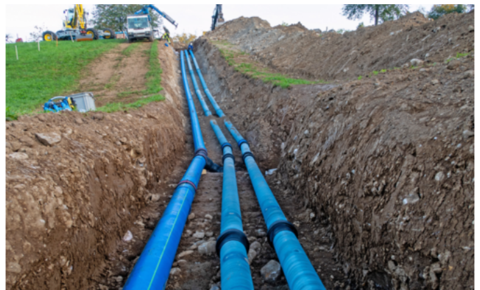
Leitungsbauten Reservoir Blattweid
