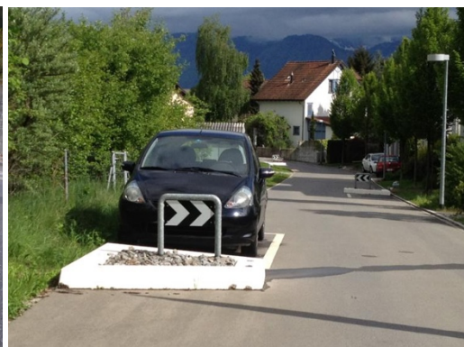
Abbildung 35: Beispiel Parkfeld mit baulichem Schutz
